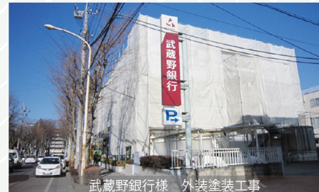
武蔵野銀行様 外装塗装工事
