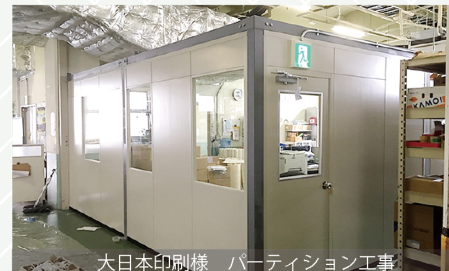
大日本印刷様 パーティション工事
