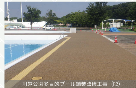
川越公園多目的プール舗装改修工事（R2）
