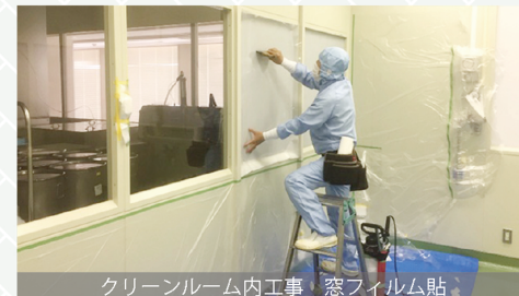
クリーンルーム内工事 窓フィルム貼
