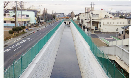
江川流域都市下水路本復旧工事（下流区間）（H31）
