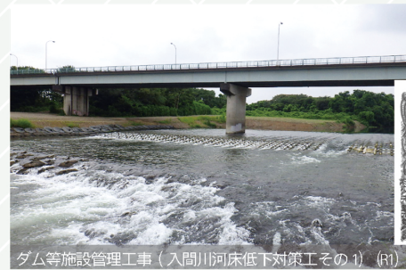
ダム等施設管理工事（入間川河床低下対策工その 1）（R1）
