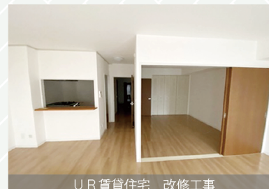
UR 賃貸住宅 改修工事
