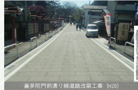
喜多院門前通り線道路改築工事（H28）
