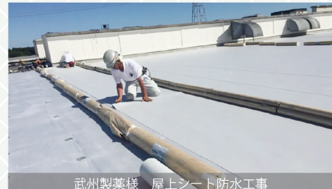
武州製薬様 屋上シート防水工事
