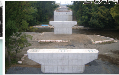
新高麗川橋橋脚工（H26） 2014
