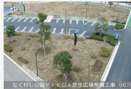
なくわし公園 P I K O A 芝生広場整備工事（H27）
