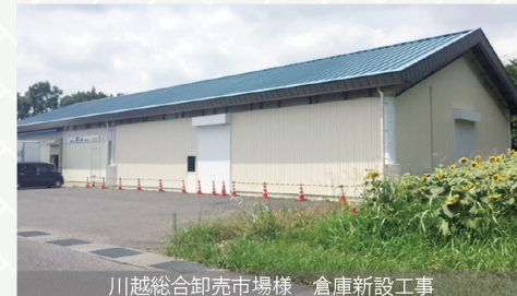
川越総合卸売市場様 倉庫新設工事
