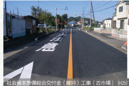
社会資本整備総合交付金（維持）工事（古市場）（H25）
